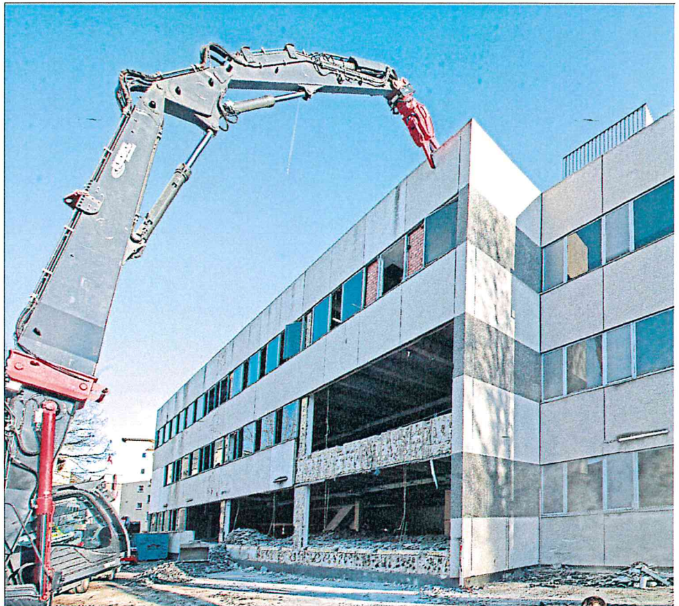
In sechs Wochen soll das Gebäude abgetragen sein.
